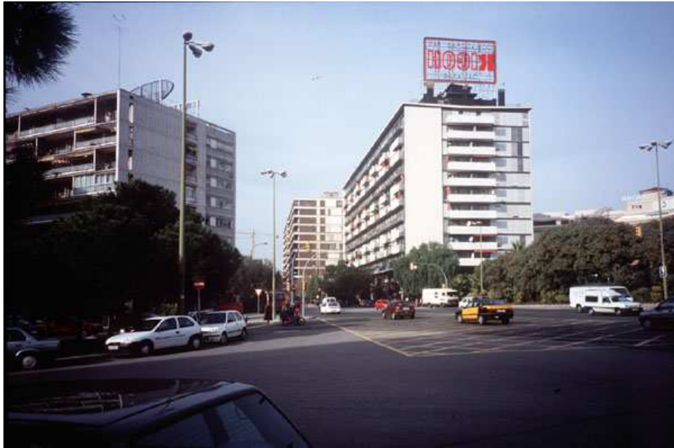
Figura 1 – Edifício Mitre [foto da época da inauguração]
